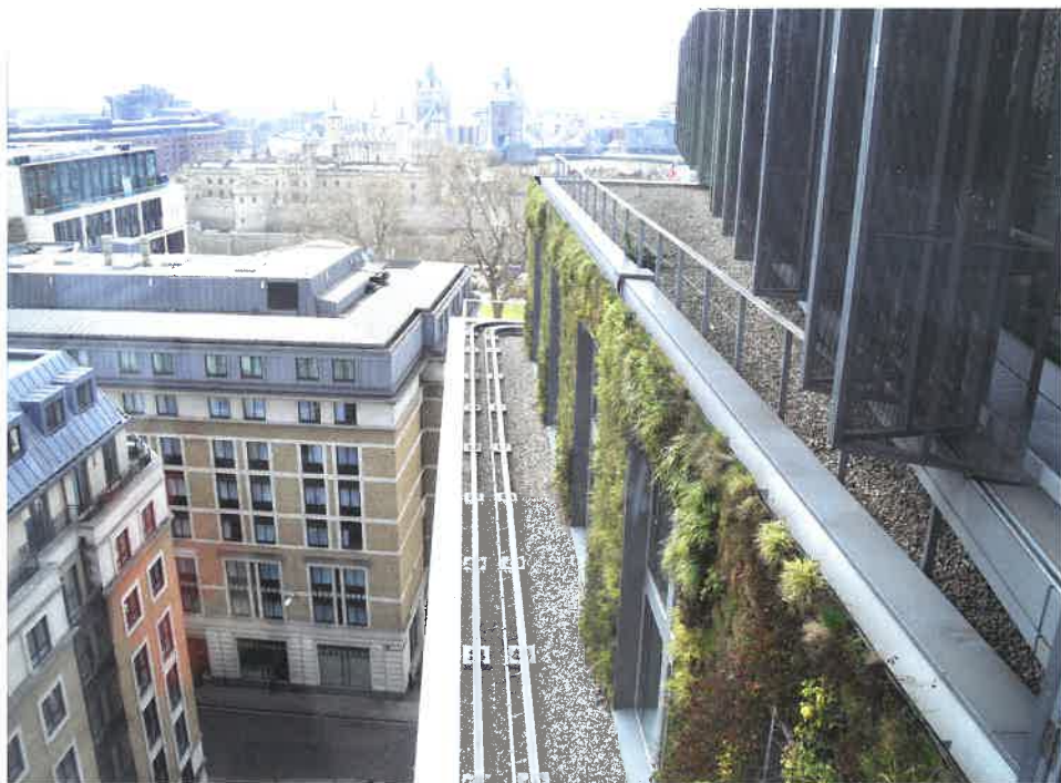
Frost Landscapes heeft voor het Doubletree Hilton een groene gevel met een bakkensysteem gemaakt op de 11de verdieping met 184.000 planten. Ondanks de grote hoogte houdt deze beplanting zich erg goed.
